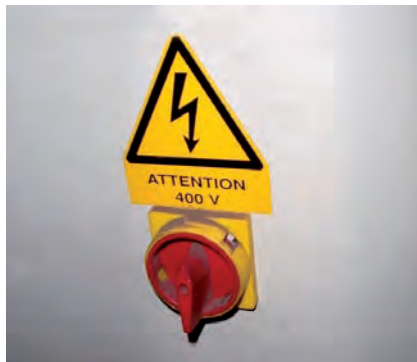
Figura 2. Interruptor-seccionador.
