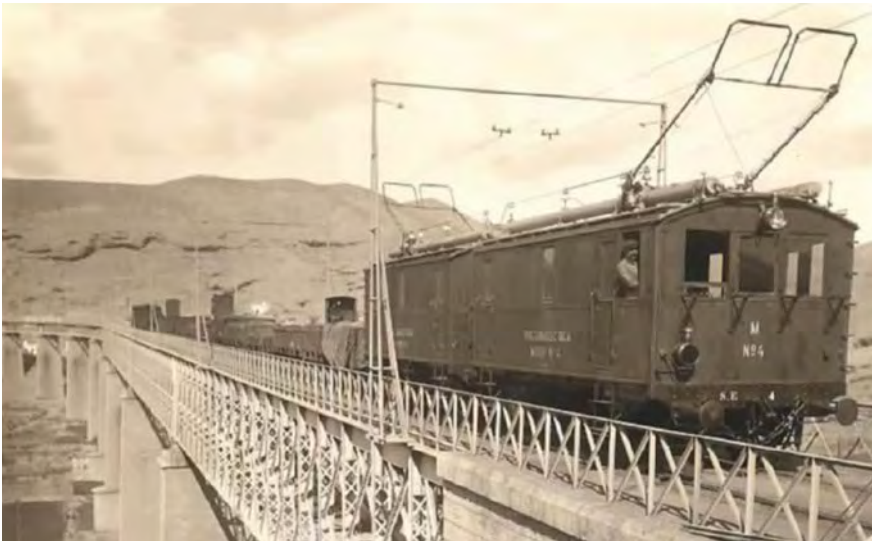
Figura 1. Inauguración del tendido de la línea aérea del ferrocarril eléctrico entre Gergal y Santa Fe (Almería) el 10 de abril de 1909, viaducto del Andarax. Tren de tracción eléctrica.
