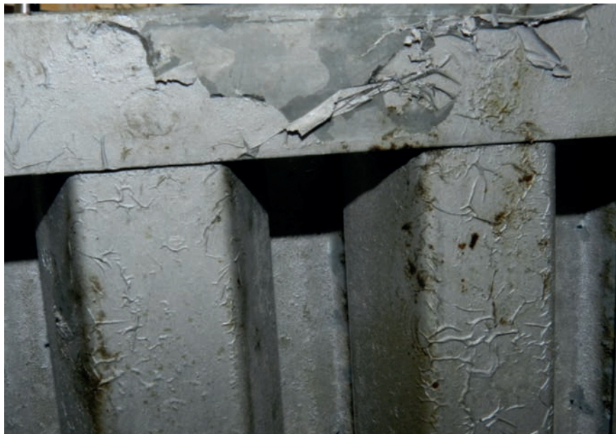
Figura 6. Filtro de cocina (modelo de lama) pintado con pintura que se desprende y retirado a un nuevo cliente. Foto: Sercaval.
