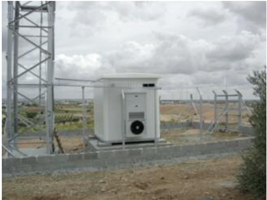
Figura 3. Fotografía de una estación base en construcción.
