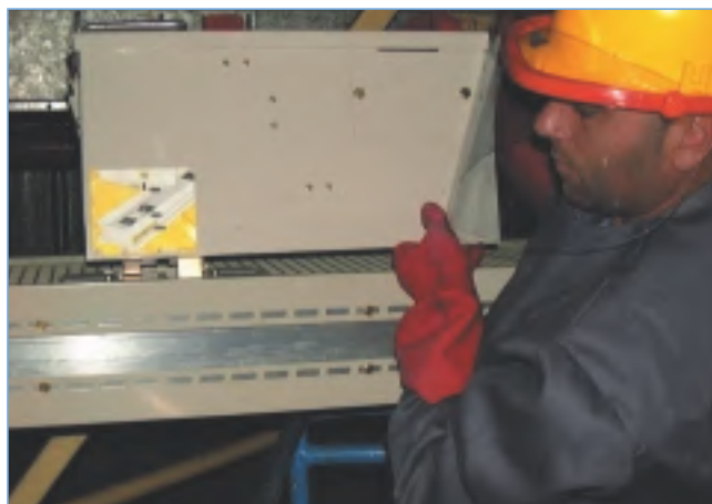
Figura 7. Operación de pinchado de una caja de derivación
