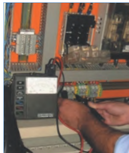
Figura 8. Comprobación del aislamiento de la acometida.
