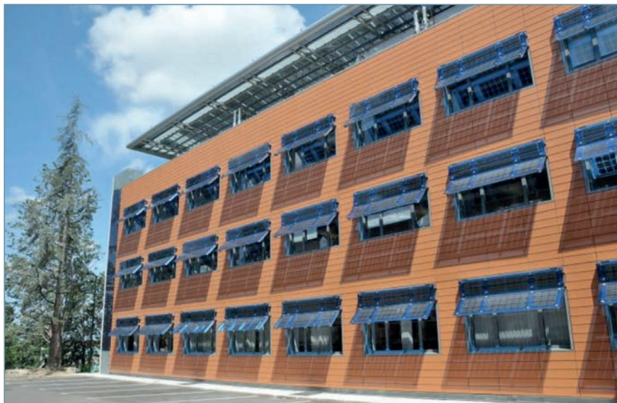
Figura 3. Edificio 70 del CIEMAT. PSE-ARFRISOL.
