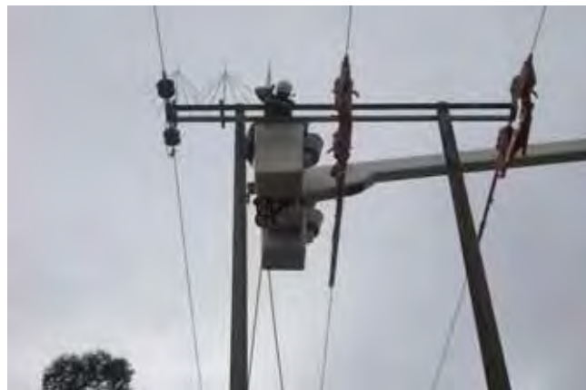
Figura 16. Instalación sistema antiposada tipo paraguas.
