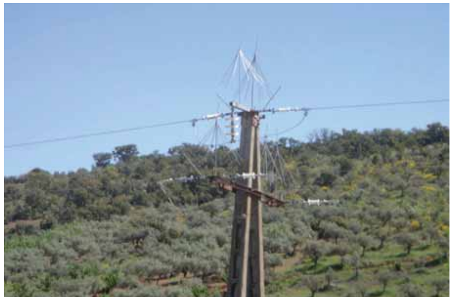
Figura 12. Montaje de alargadera y antena.
