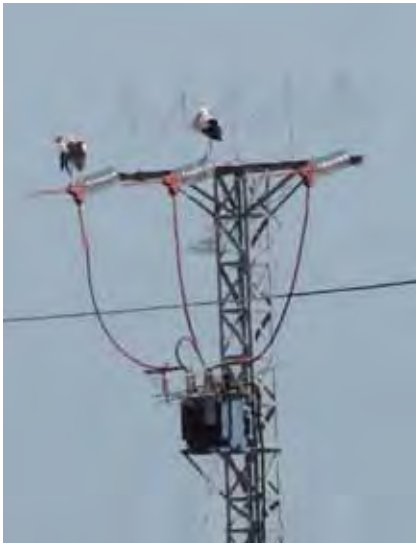
Figura 6. Las cigüeñas echando palos sobre el transformador.
