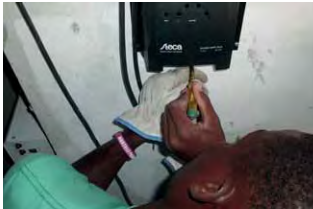
Conexión de un regulador fotovoltaico por un alumno. / Foto: S. L. P.
