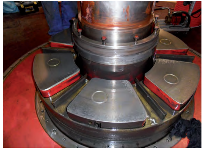
Figura 7. Trabajos de montaje de circuito de inyección de aceite al cojinete pivote del grupo hidroeléctrico debido a rediseño por análisis de mantenimiento preventivo (Fuente: Endesa Generación).
