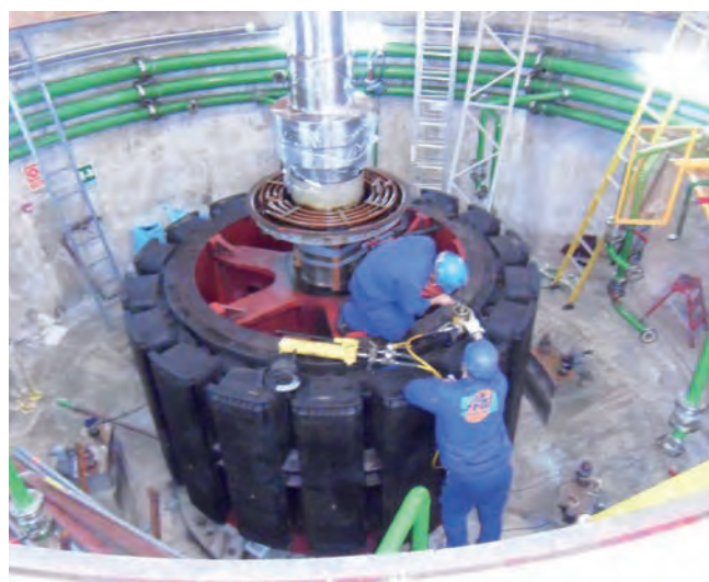
Figura 10. Desmontaje y trabajos de mejora de alternador (polos del rotor, desacople estrator-rotor) de grupo hidroeléctrico debido a análisis de datos de mantenimiento predictivo-EDAS alternador (Fuente: Endesa Generación).
