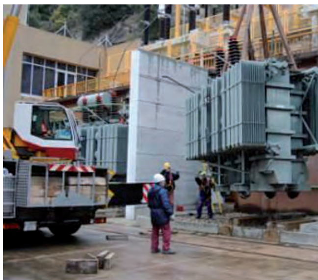
Figura 9. Trabajos de sustitución de transformador de potencia debido a análisis de datos de mantenimiento predictivo (análisis aceite dieléctrico) (Fuente: Endesa Generación).
