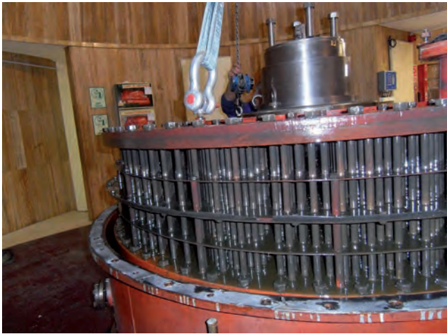
Figura 6. Trabajos de reparación de circuito refrigerante cojinete por análisis de mantenimiento mediante recorridos de inspección y monitorización de parámetros (Fuente: Endesa Generación).
