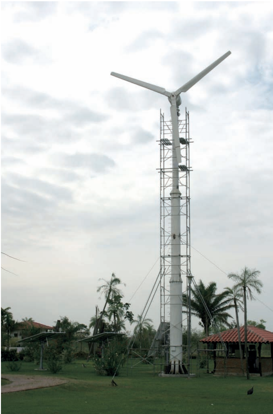
Figura 3. Aerogeneradores para una instalación rural aislada en construcción en Santa Cruz de la Sierra, motor económico de Bolivia y una de las ciudades con mayor crecimiento demográfico de América del Sur. / Foto: S.L.P.
