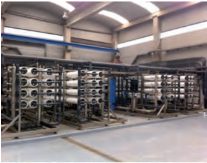
Figura 5. Vista general de bastidores de ósmosis, módulos de membranas en espiral (imagen cedida por EMSSA).
