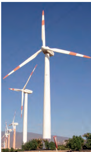
Figura 8. Molino aerogenerador rotor tripala. TM Agüimes. Isla de Gran Canaria. Fotos: V. M. Cabrera García.
