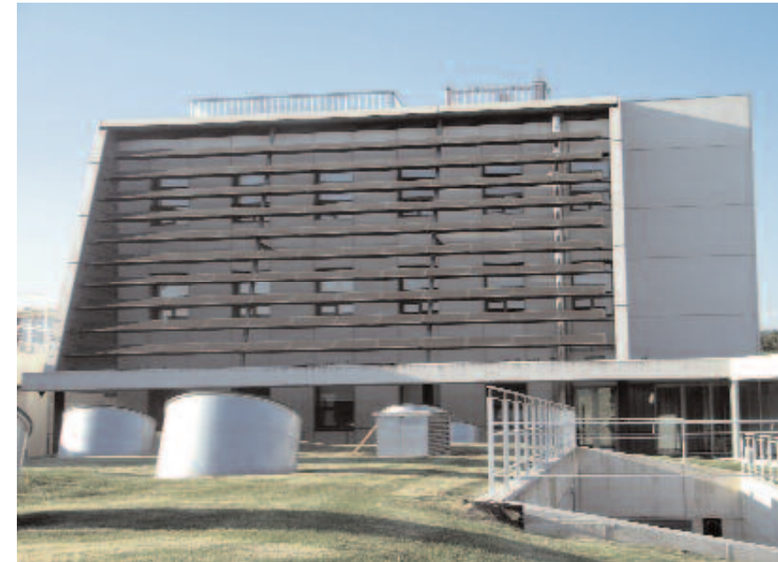
Figura 11. Lamas fotovoltaicas en la fachada sur del edificio de la sede de CENER en Sarriguren, Navarra.
