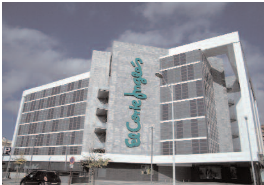
Figura 10. Fachada sur fotovoltaica del centro comercial El Corte Inglés en Albacete.
