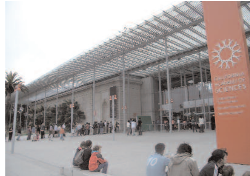
Figura 12. Gran marquesina con módulos fotovoltaicos a la entrada de un museo en California.
