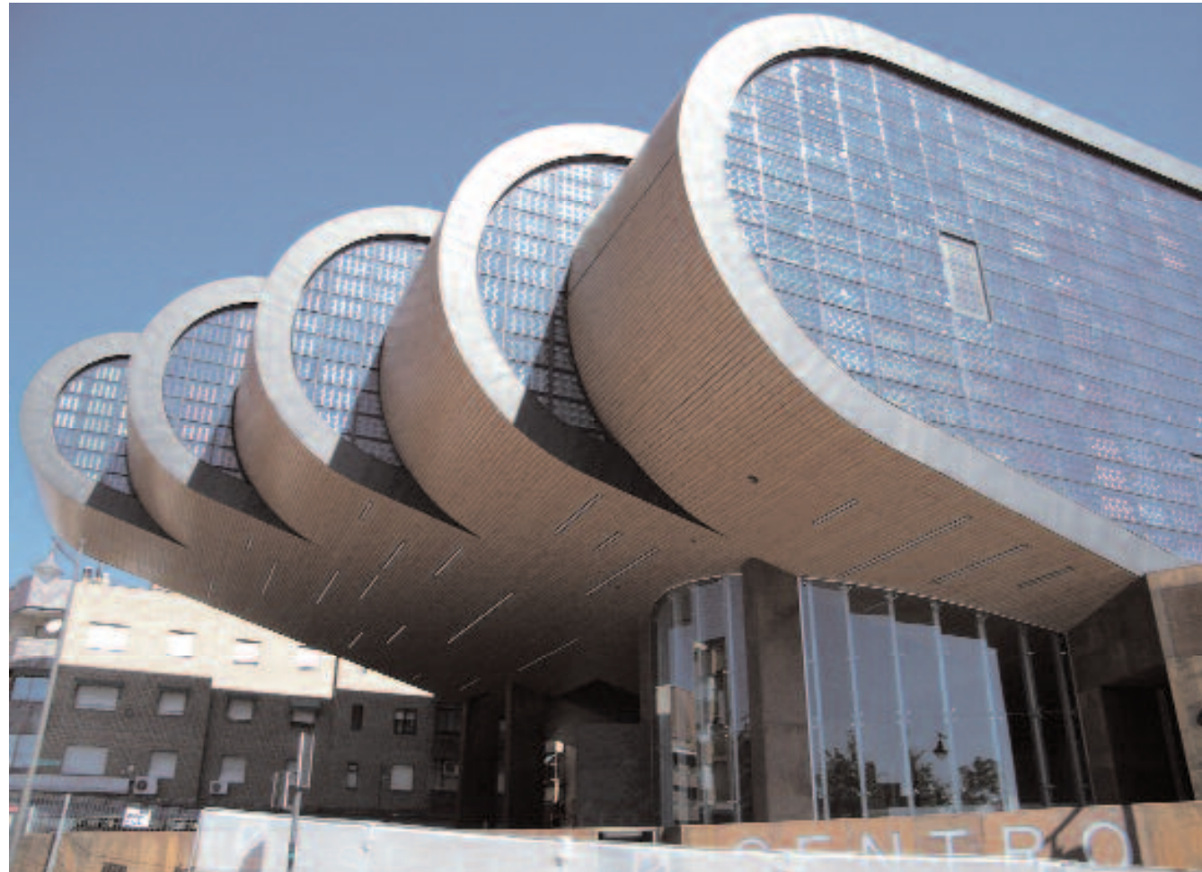
Figura 6. Fachada sur del centro de arte de Alcobendas, Madrid. La geometría de la fachada arroja sombras sobre parte de los módulos fotovoltaicos.
