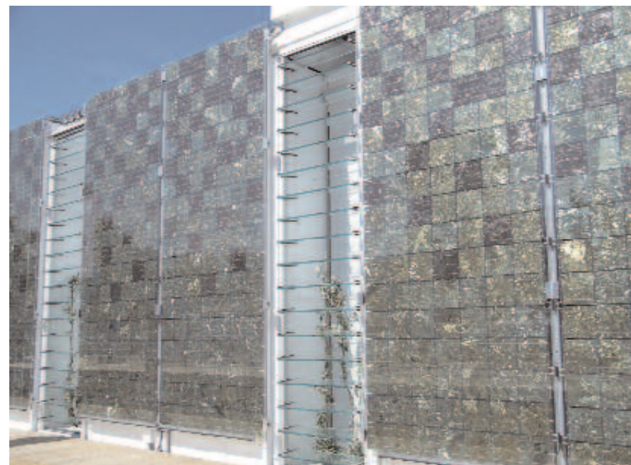
Figura 4. Fachada fotovoltaica con células de distintas tonalidades. Edificio prototipo para Solar Decathlon de la Universidad de Ciencias Aplicadas de Stuttgart.
