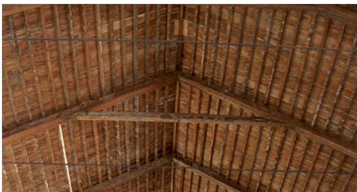
De izquierda a derecha y de arriba a abajo: pilares de fundición gris con capiteles, en fábrica azucarera Nuestra Señora del Pilar en Motril (Fuente: elaboración propia, abril de 2008); forjado de bovedillas en edificación rehabilitada de la fábrica azucarera Nuestra Señora del Pilar en Motril (Fuente: elaboración propia, abril de 2008); estructura de cerchas de madera para cubierta en edificación rehabilitada de la fábrica azucarera Nuestra Señora del Pilar en Motril Fuente: elaboración propia, abril de 2008.
