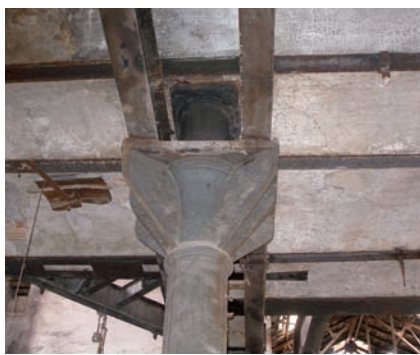
Detalle de prolongación de pilar de fundición gris en la fábrica de San Isidro (Granada, 1901). Fuente: Elaboración propia, noviembre de 2007.
