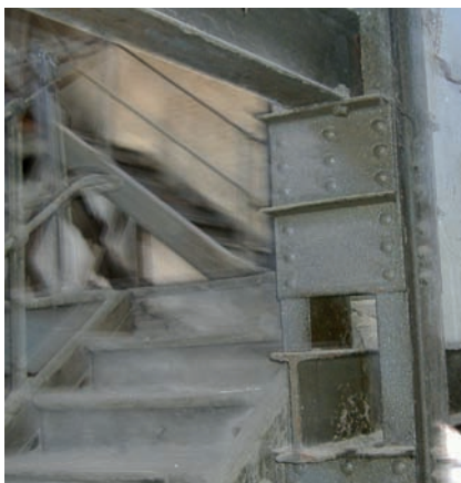
Pilares de láminas de acero en la alcoholera de San Isidro (Granada, 1908). Fuente: elaboración propia, noviembre de 2007.
