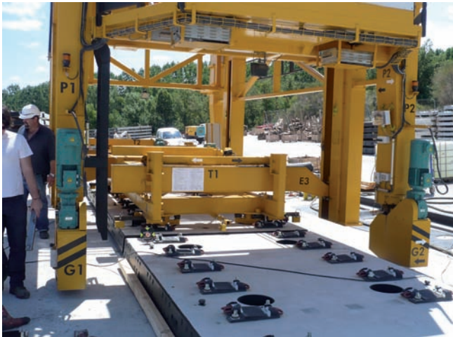
Figura 7. Colocación de la placa.
