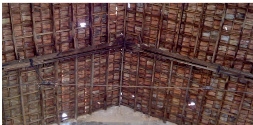
Estructura de cerchas de madera en la fábrica El Señor de la Salud, en Santa Fe (1889). Fuente: Elaboración propia, julio de 2009
