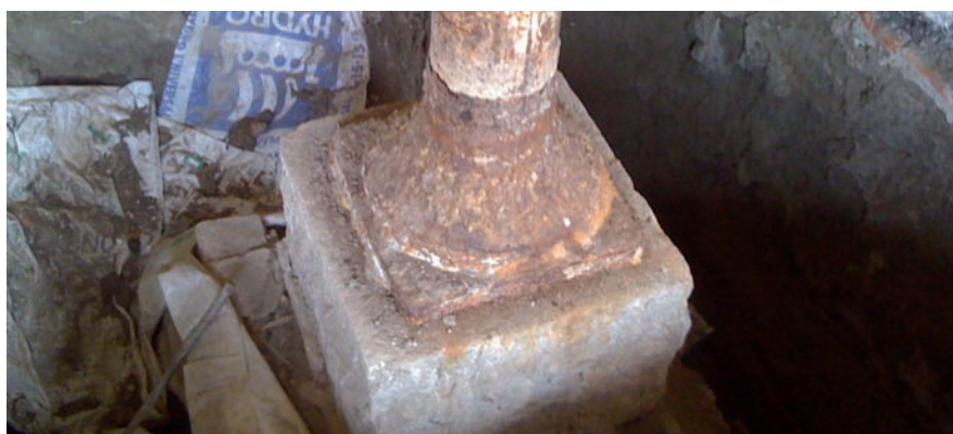
Cimentación de pilar de fundición gris mediante roca aislada en la fábrica El Señor de la Salud, en Santa Fe (1889). Fuente: Elaboración propia, julio de 2009.
