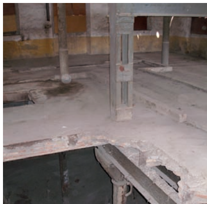
Prolongación de pilar con variación en la tipología en la fábrica de San Isidro (Granada, 1901). Fuente: Elaboración propia, noviembre de 2007.
