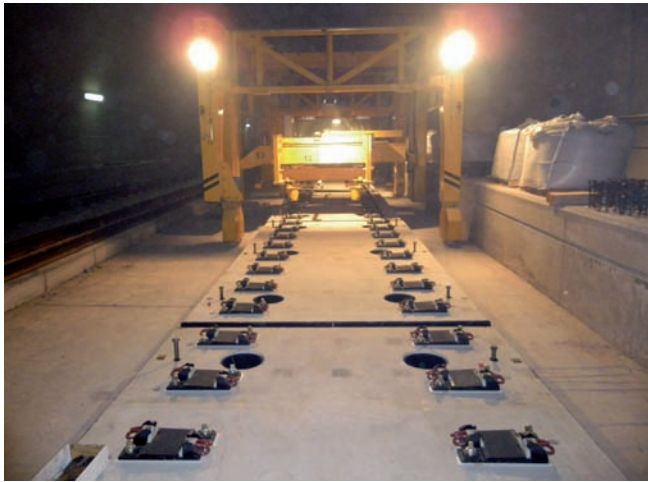
Figura 9. Colocación de la placa en túnel.
