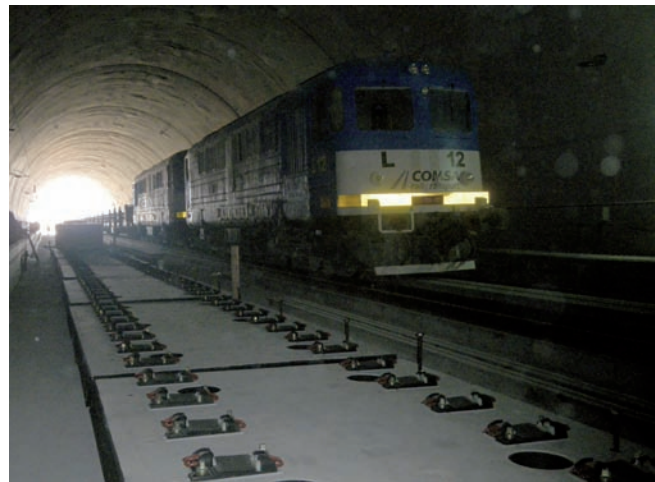
Figura 10. Placas montadas y paso del tren por la vía par en el túnel de Horcajada.
