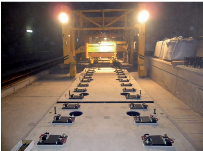
Figura 9. Colocación de la placa en túnel.
