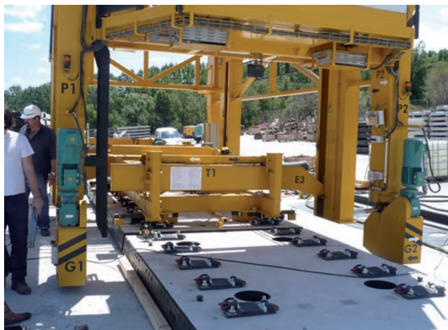
Figura 7. Colocación de la placa.
