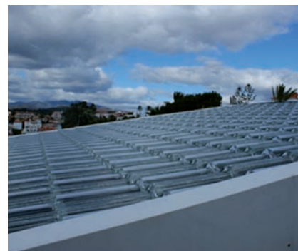
Tejas solares transparentes en Mijas. Foto: Agencia Andaluza de la Energía
