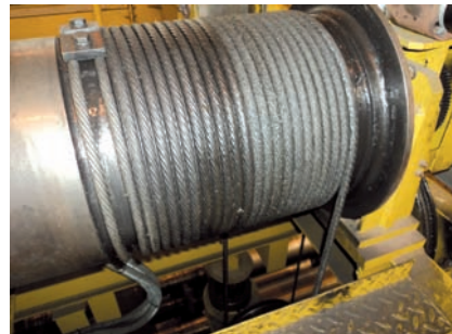
Figura 2. Ejemplo de componente: cable de elevación de puente grúa. (Foto: gentileza de ArcelorMittal Sagunto.)
