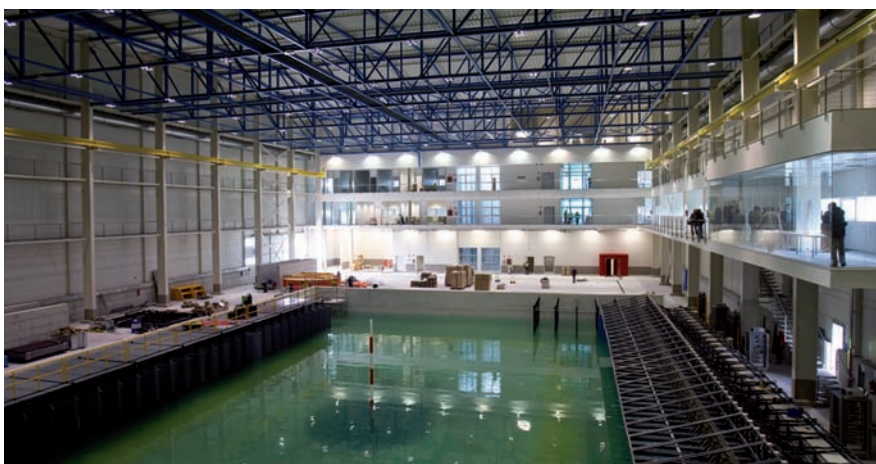
Instalaciones del Cantabria Coastal and Ocean Basin. Foto: CCOB.
