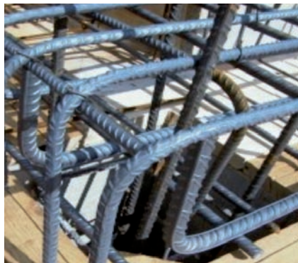
Figura 7. Detalle del doblado de las armaduras de hormigón en una obra.
