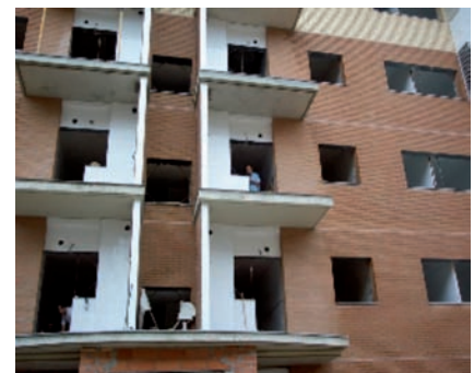
Figura 2. No existe protección.
