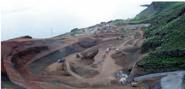
Construcción de los depósitos superior e inferior de la central.
