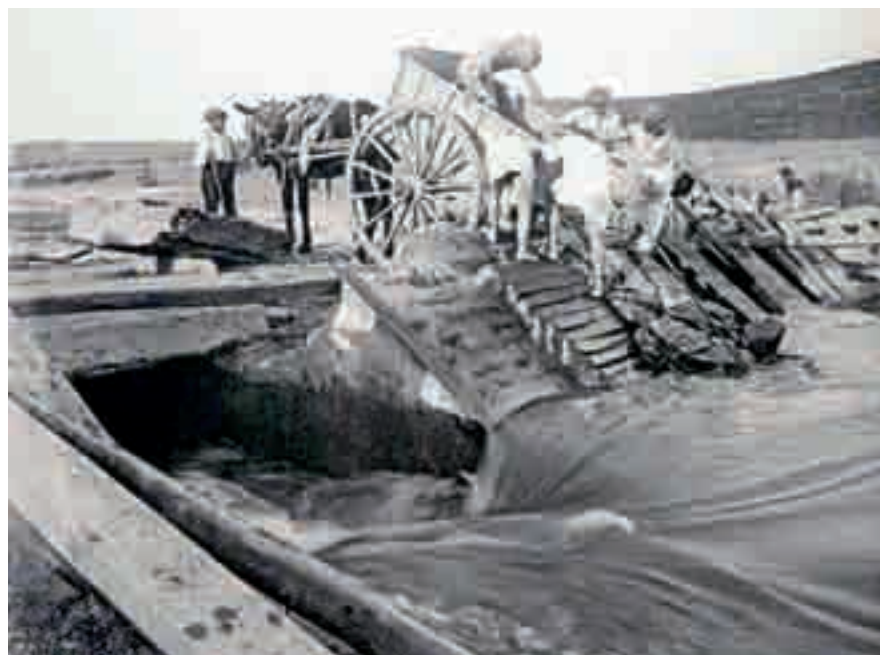
Figura 5. Fotografía de las obras. El material se transportaba con los medios de la época, principalmente, carros arrastrados por mulas
