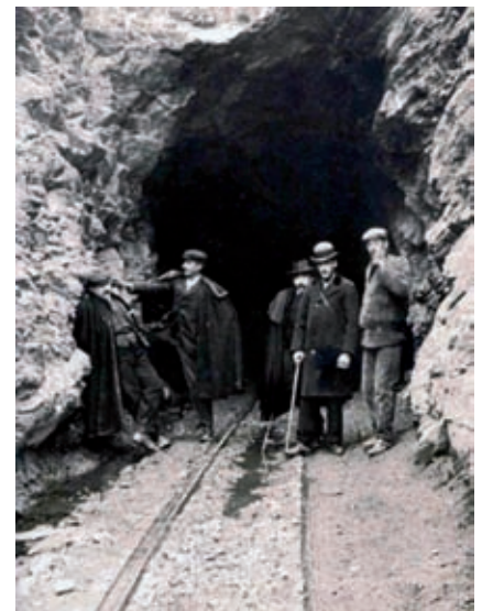
Figura 4. Obras del túnel
