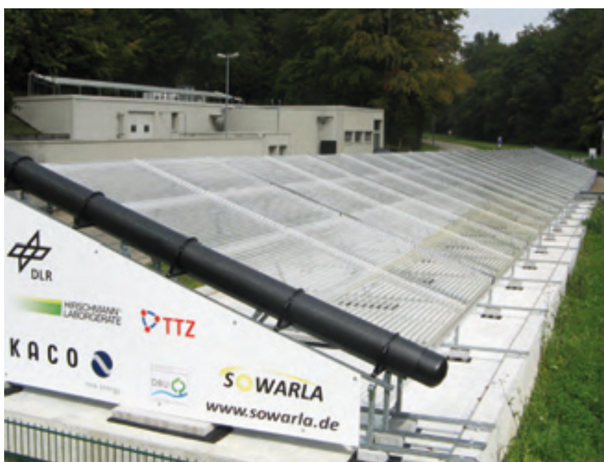
El sistema piloto (Solare Wasserreinigungsanlage Lampoldshausen, Sowarla) opera en Lampoldshausen y es capaz de limpiar totalmente el agua que se usa para enfriar los sistemas de motores empleados en el Instituto de Propulsión Espacial de DLR, que está contaminada con los restos de combustible utilizados. / DLR
