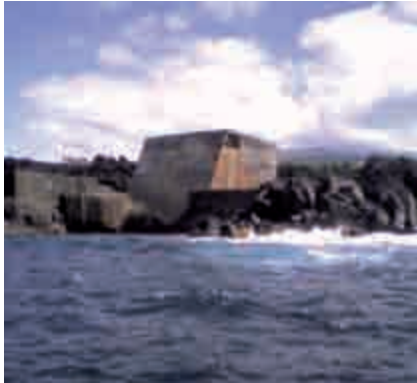
Figura 11. Generador OWC instalado en Pico (Islas Azores).
