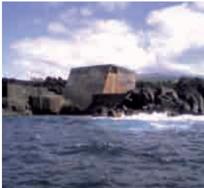
Figura 11. Generador OWC instalado en Pico (Islas Azores).
