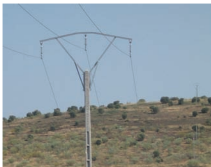
Figura 21. Cambio de aislamiento (después).
