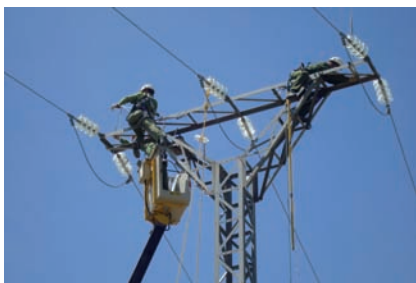
Figura 33. Instalación de antinidos tipo paraguas.
