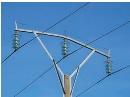
Figura 25. Antiposada tipo hilo (en este caso, combinado con aislador U100 en la parte superior de la cadena).
