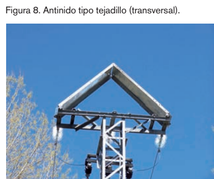
Figura 8. Antinido tipo tejadillo (transversal).
