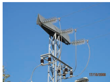
Figura 7. Antinido tipo tejadillo (longitudinal).
