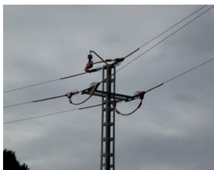
Figura 26. Forrado de partes en tensión.
