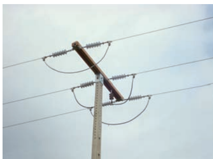
Figura 23. Cruceta mixta de madera.
