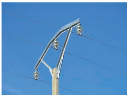
Figura 24. Antiposada tipo "L".
