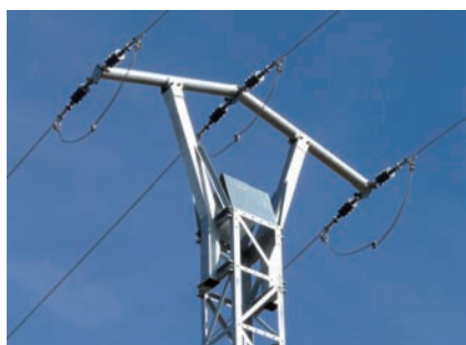
Figura 11. Cruceta tubular (con tejadillo inferior).
