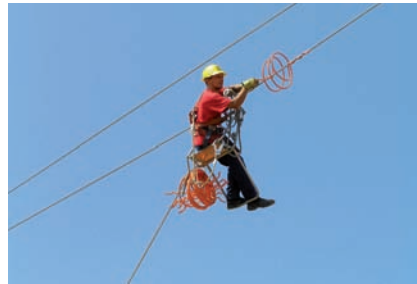
Figura 27. Instalación de sistema contra la colisión (en este caso, baliza tipo espiral).
