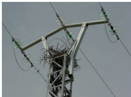
Figura 10. Cruceta tubular (con nido en formación).
