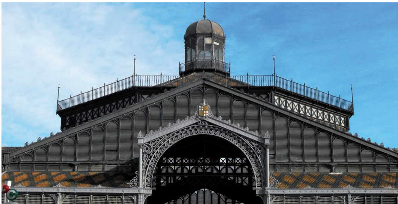
Mercado del Born, una de las obras más representativas de la arquitectura del hierro en Barcelona (1876). / Óscar Giménez
