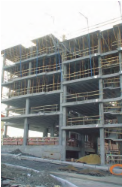
Figura 8. Es recomendable que las construcciones colindantes posean los forjados de cada planta al mismo nivel.
