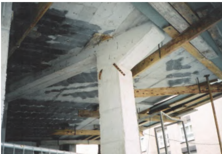
Figura 3. Otra vista de la ménsula que aparece en la figura 2, en donde se puede apreciar la viga posterior.
