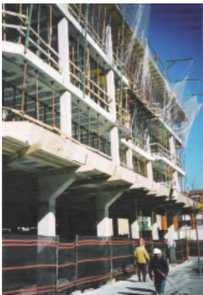
Figura 1. Incremento de la volumetría, a partir de la primera planta, mediante ménsulas cortas.
