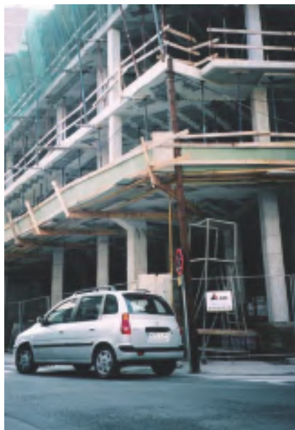
Figura 2. Otro edificio en el que se utiliza una ménsula corta en el esqueleto resistente.
