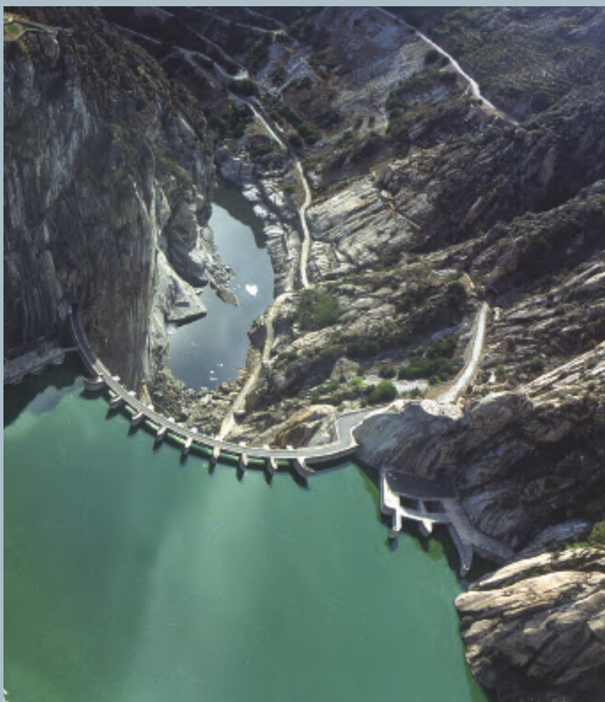
Central hidráulica de Aldeadávila (Salamanca) en el río Duero construida en 1962. / IBERDROLA
