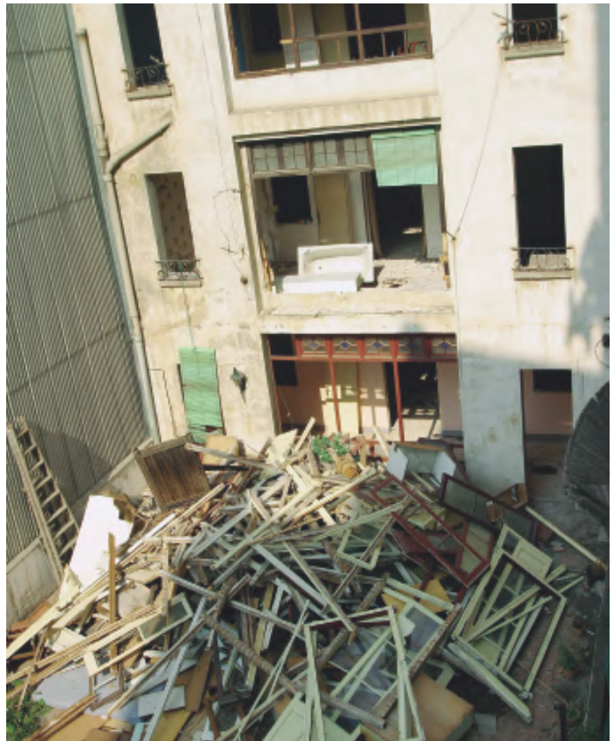
Residuos de la demolición de un edificio.
