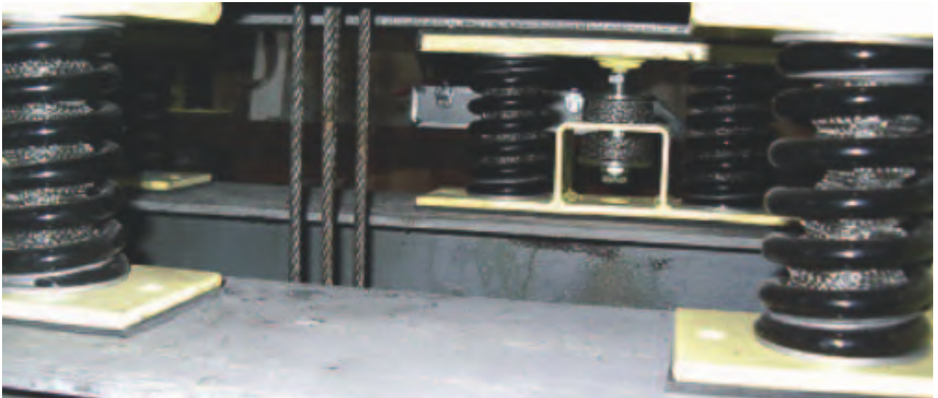
Figura 9. Sistema aislador lineal antivibratorio ideal para bancadas de máquinas de ascensores basado en resortes helicoidales con cojines de malla de acero en su interior que se apoyan exteriormente en unas alfombrillas de caucho. Todo el conjunto consigue un óptimo resultado antivibratorio en un rango de frecuencias mayor.
