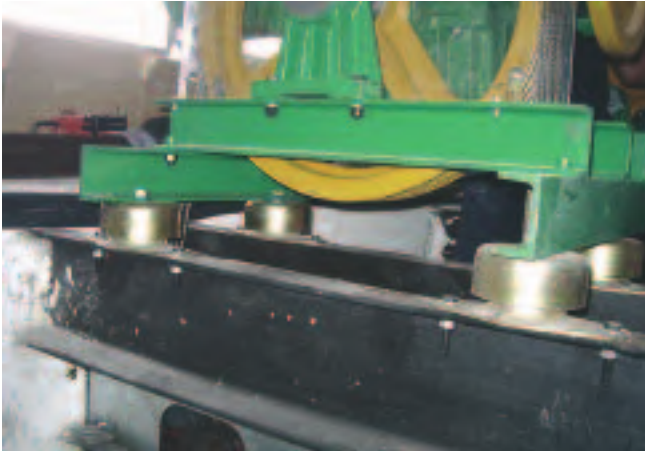
Figura 2. Máquina tractora con desvío montada sobre un antivibratorio especial de caucho y metal.
