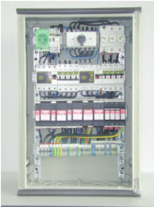
Figura 2. Distribución convencional de un armario de control.
