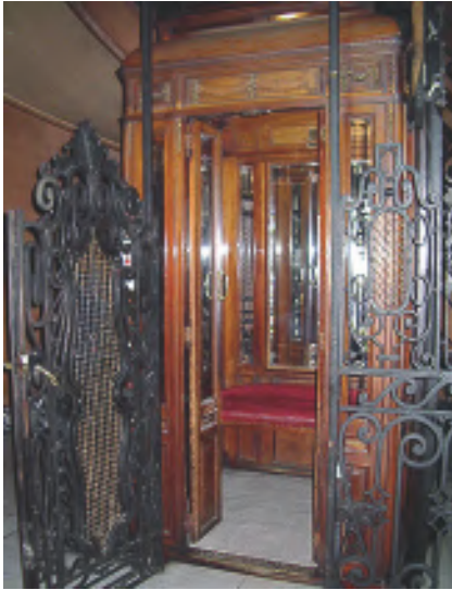
Foto 2. Cabina y cerramiento de un ascensor. Las primeras cabinas se hacían muy amplias, debido a que no había ninguna reglamentación que lo limitara, y como la velocidad de desplazamiento era lenta se colocaban asientos para la comodidad de los usuarios privilegiados de las altas sociedades de la época.
