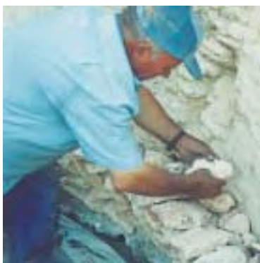
Figuras 8 y 9. Creación de la bóveda del horno.
