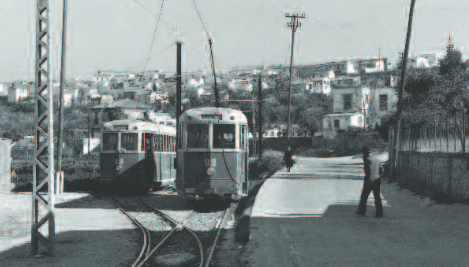
Cruce de tranvías en la estación de Cajar (Granada).
