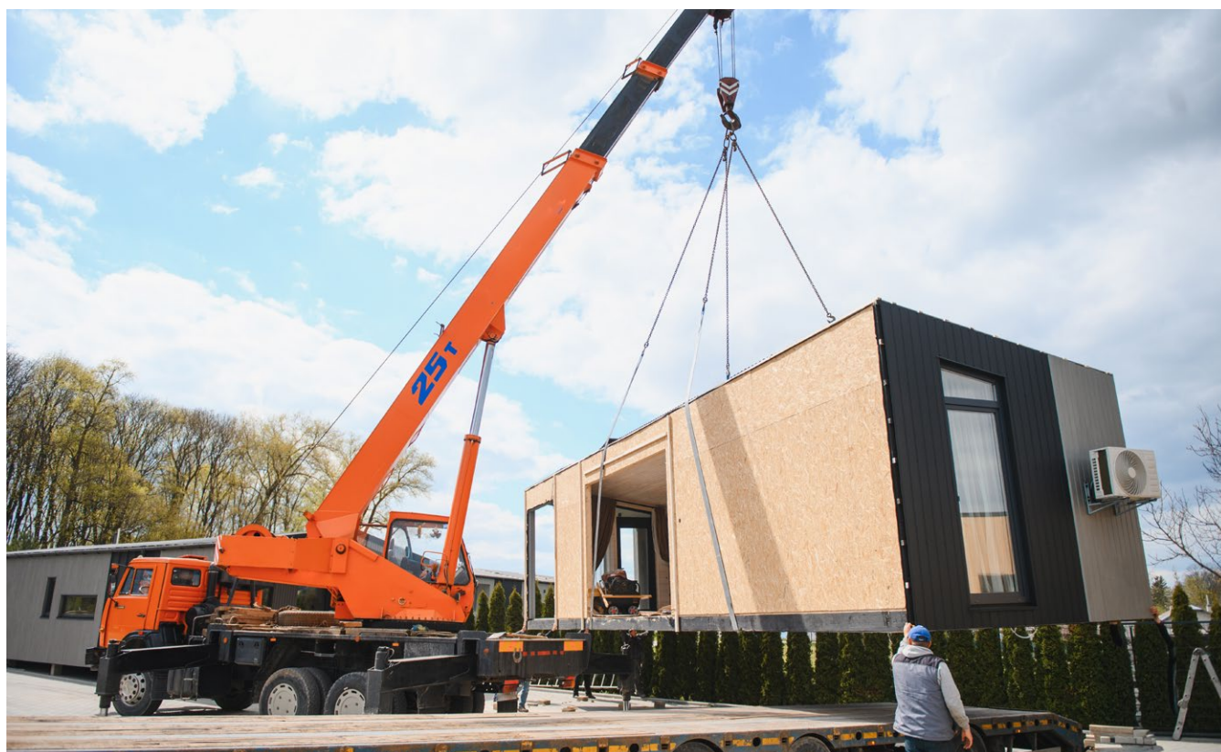
La fase de montaje en la edificación off-site exige una planificación logística milimétrica, donde las grúas de gran tonelaje sustituyen la actividad artesanal por el ensamblaje de componentes de alta precisión. Foto: Shutterstock.
