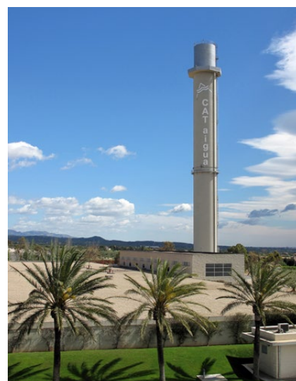
Estación de Tratamiento de Agua Potable, ETAP. (Fuente: CAT).
