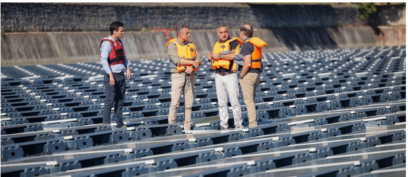
Carlos Novillo visita las instalaciones de Canal, en la planta flotante fotovoltaica de Torrelaguna.
