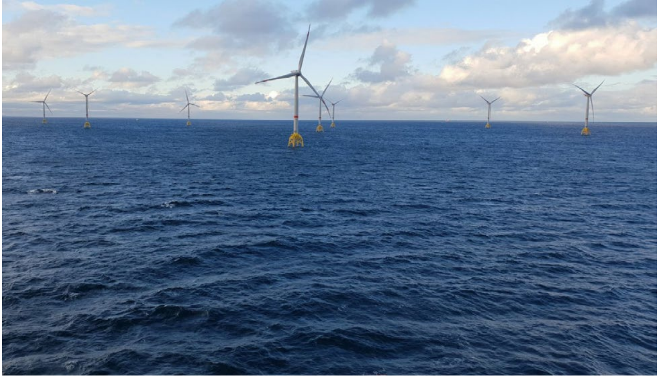
Figura 10: Fotografía de parque eólico cimentado en Alemania. Fuente: Archivo propio.
