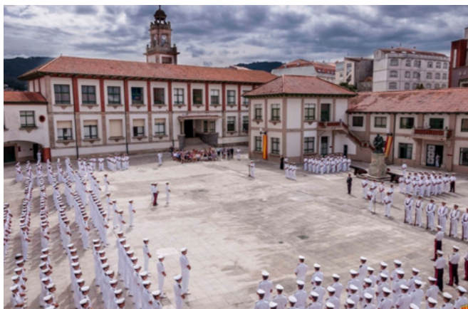
Patio de aulas de la ENM.
