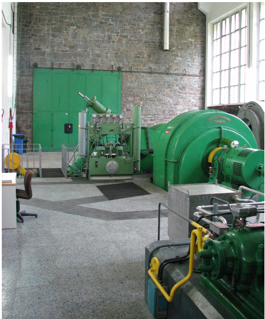
Figura 2. Minicentral hidroeléctrica del Pirineo de Girona. Fuente: Enel Power Generation Hydro.
