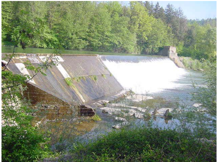
Figura 1. Azud minicentral hidroeléctrica. Fuente: Enel Power Generation Hydro.
