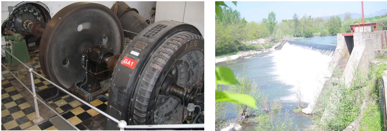
Figura 5. Minicentral hidroeléctrica y azud de captación de canal (fuente: Enel Power Generation Hydro).
