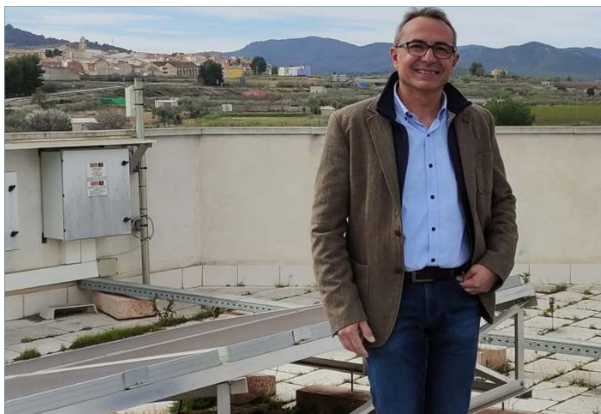
Francisco Espín, junto a la instalación fotovoltaica de autoconsumo instalada en la terraza del edificio donde ubica su empresa de ingeniería.
