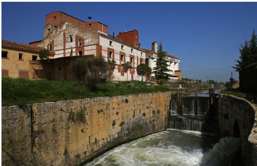
Esclusa nº 33 y fábrica de harinas, a su paso por Villamuriel de Cerrato (Palencia).
