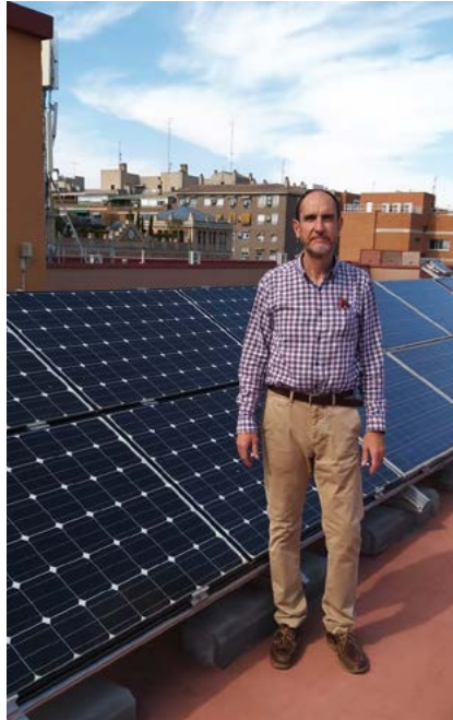
Julio Amador muestra la terraza solar instalada en la ETSIDI de la Universidad Politécnica de Madrid.
