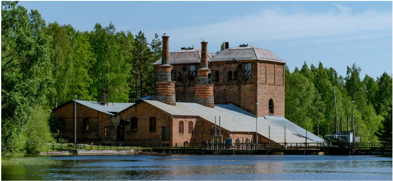
Antigua fábrica de acero en Suecia. Foto: Shutterstock.
