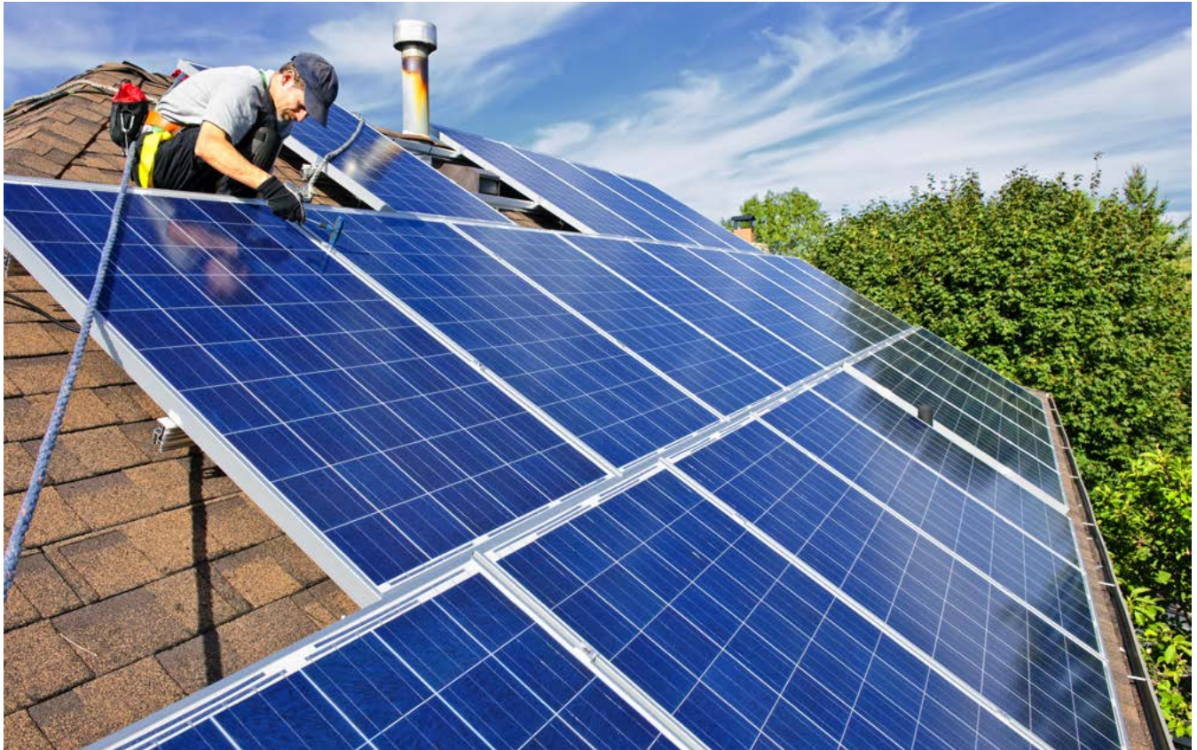
Un operario instala placas solares para el autoconsumo en el tejado de una vivienda. Foto: Shutterstock.
