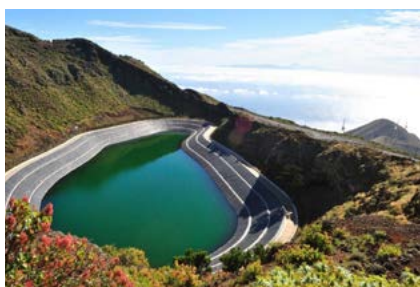
Vista del Depósito Superior. Foto: IDAE.
