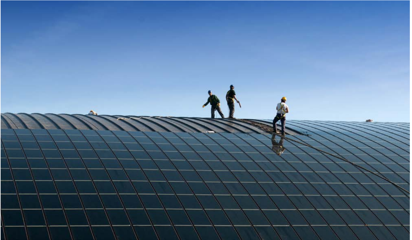
Instalación de paneles solares en el tejado de un edificio. Fuente: Shutterstock.
