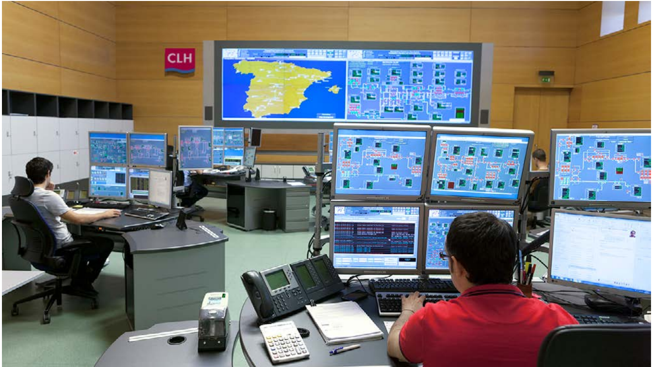
Centro de Control de Oleoductos de CLH.
