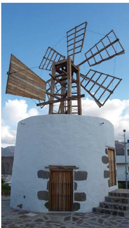
Figura 4. Molino de viento harinero sistema Romero. TM de La Aldea. Gran Canaria. Foto: Víctor M. Cabrera García.
