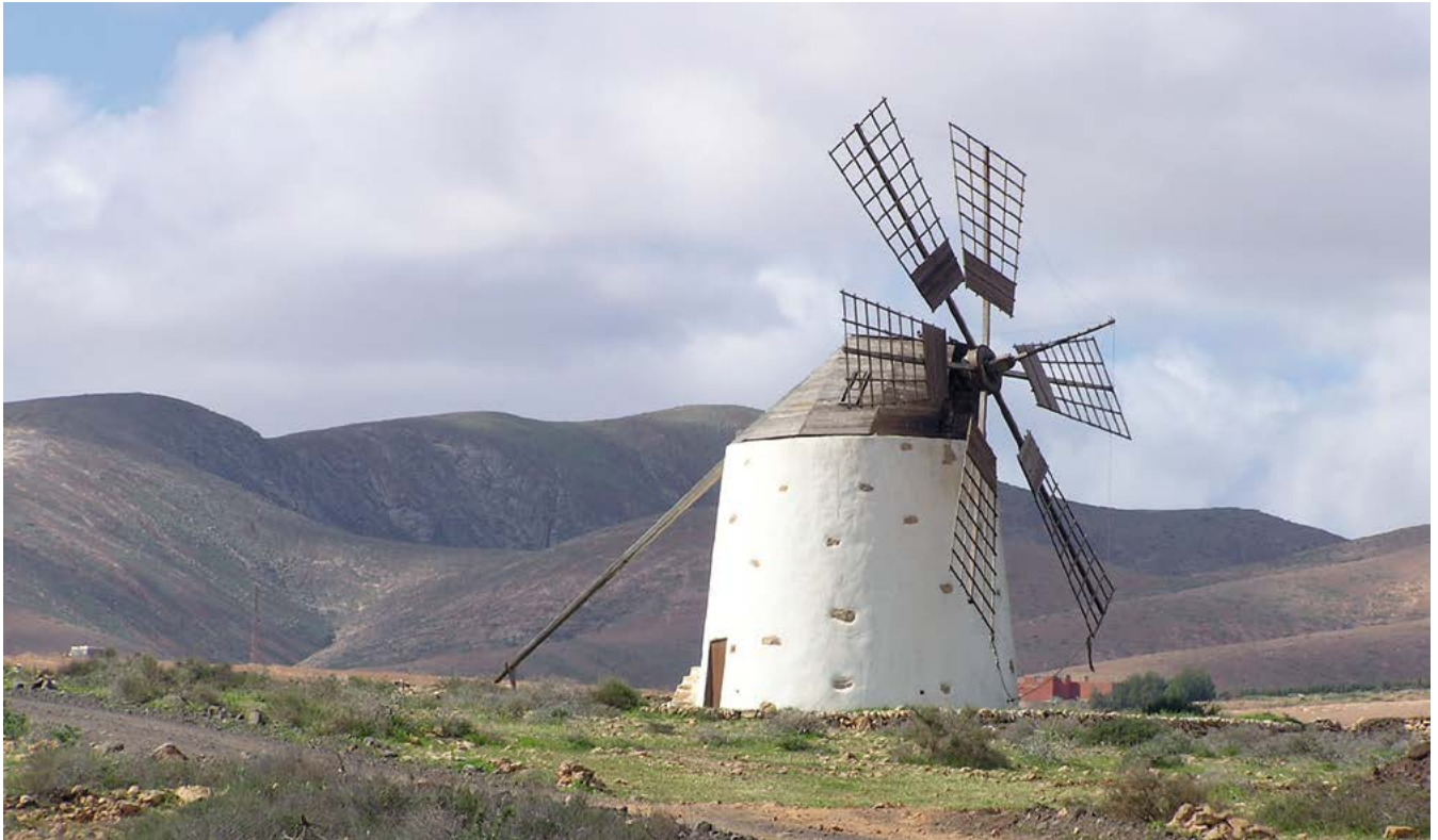
Molino de viento de tipo torre en Llanos de la Concepción, TM de Puerto del Rosario. Fuerteventura. Foto: Néstor Rodríguez Rodríguez.
