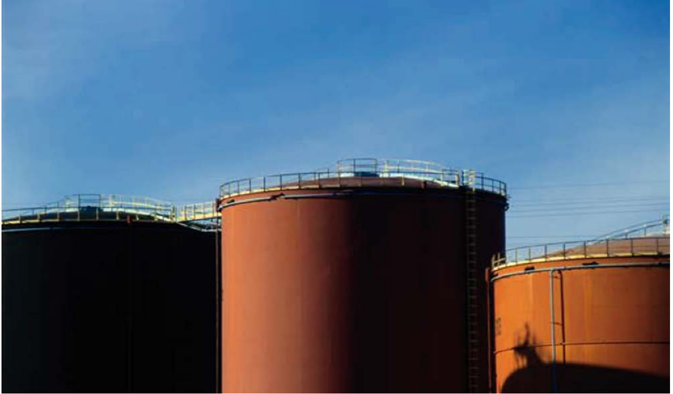
Imagen de espacios confinados. (Fuente: Wolters Kluwer.)
